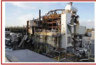
รูปที่ 1. สีสันเล็ดร่อนหลังจากการระเบิดด้านใน (ที่มา: CSB report No. 2021-04-I-OH)
