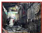
รูปที่ 1: อาการที่เสียหายจากเหตุเพลิงไหม้ที่เกิดจากแบตเตอรี่ลิเทียมไอออน
